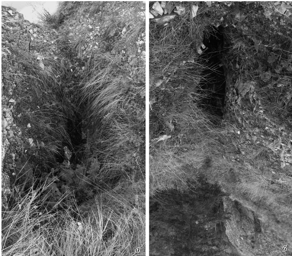
Рис. 7. Трещины бортового отпора ниже по склону от обзорной площадки «Ленские Столбы».
