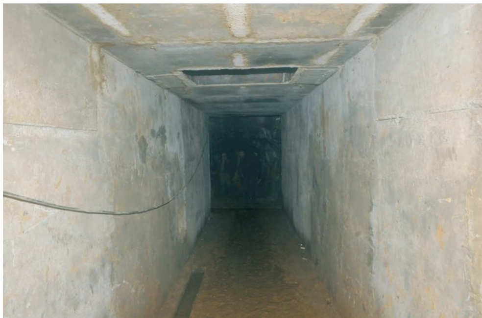
Рис. 4. Бетонный оголовок штольни 2 на соединении с Большим залом почти окончен.
