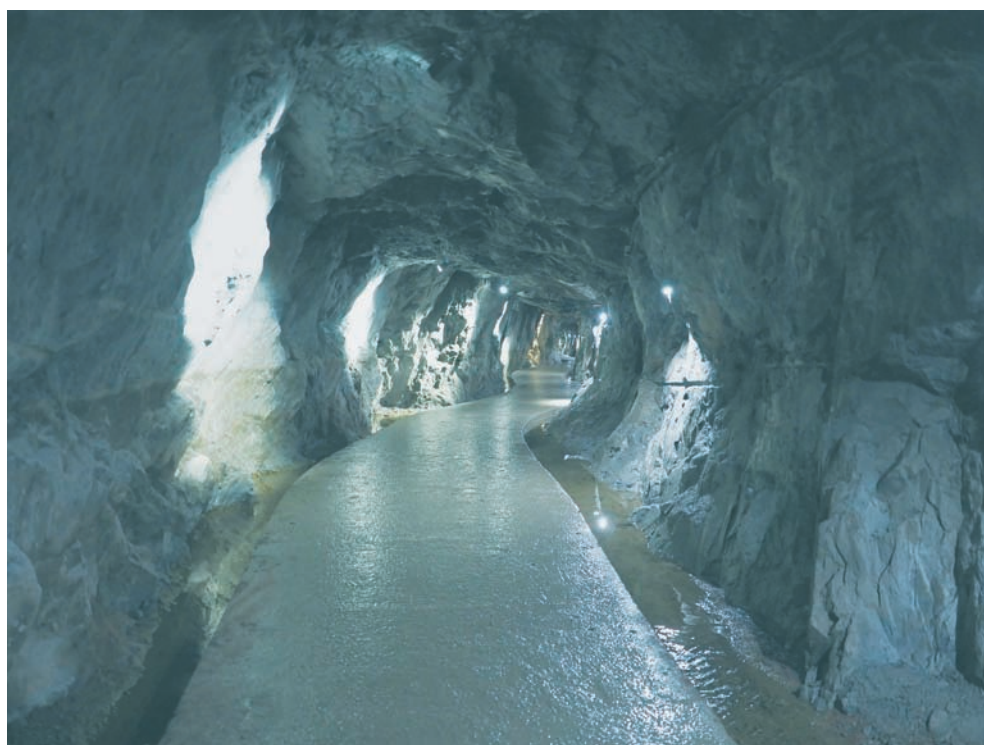
Рис. 5. Штольня 2, ведущая в Большой зал.
