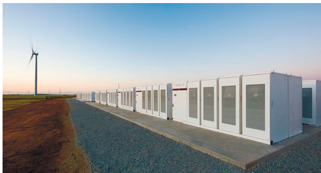
Рис. 4. Литий-ионная супербатарея мощностью 100 МВт, Южная Австралия, г. Джеймстаун [37].
